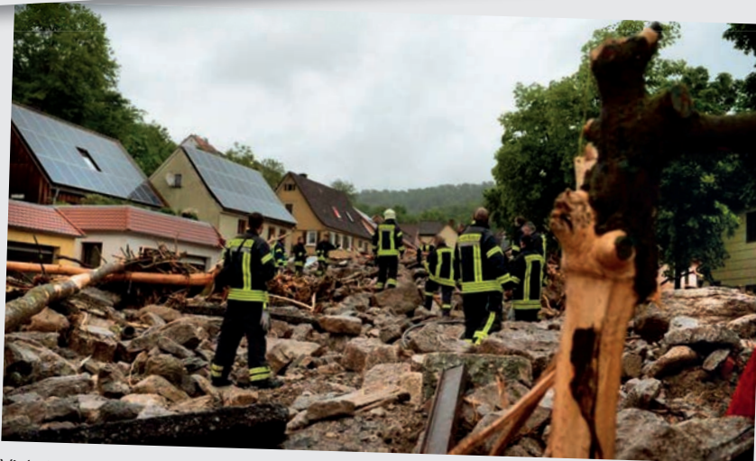
Viele Häuser sind einsturzgefährdet und mussten evakuiert werden.
